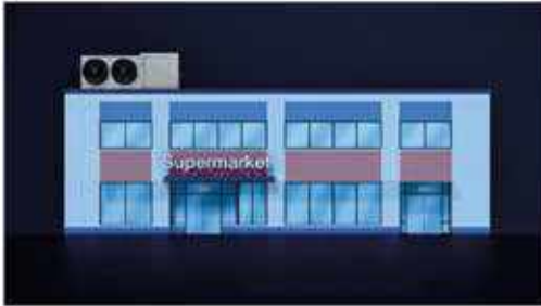
Buitenopstelling gegroepeerd Installation groupée en extérieur
